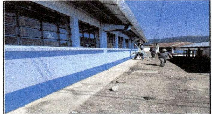
Foto 4: Ventanas en mal estado, sustitución de vidrios.
