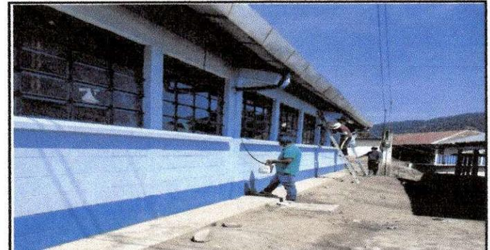
Foto 6: Pintura en muros exterior.
